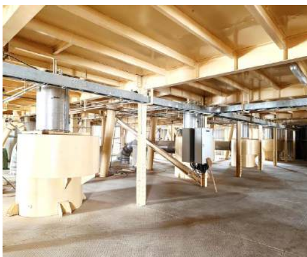
Hình 3.12 Hệ thống Cyclone lắng bụi
