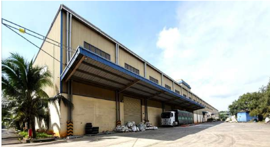
Hình 3.2 Đường ống thu gom nước mưa
