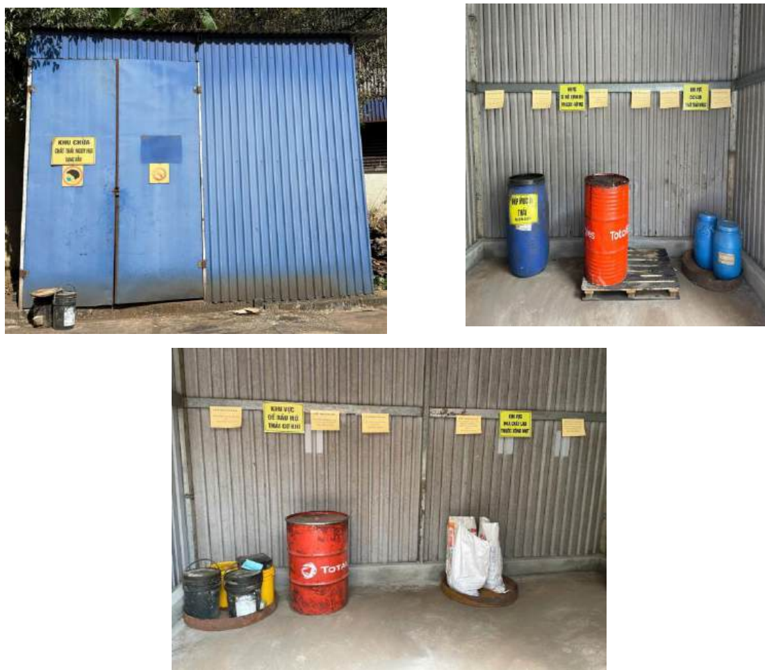
Hình 3.20 Nhà chứa chất thải nguy hại
