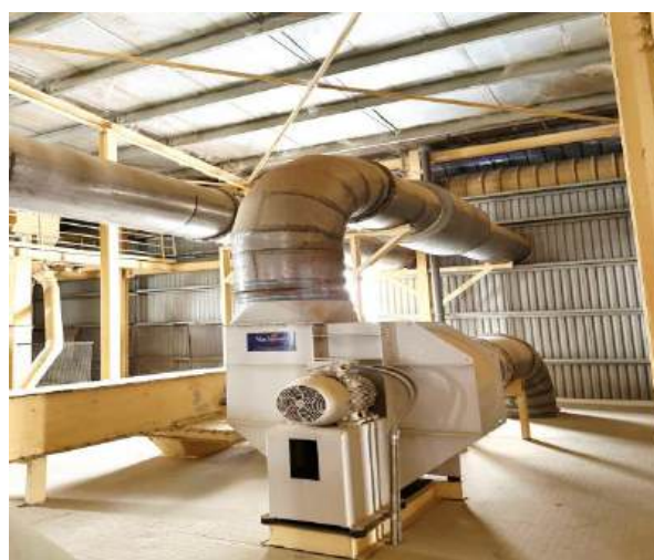
Hình 3.12 Hệ thống Cyclone lắng bụi
