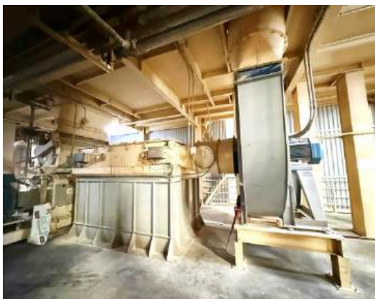
Hình 3.10 Hệ thống lọc bụi túi vải
